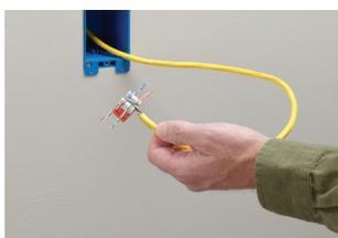
2. Determine el esquema de cableado. Coloque los cuatro pares (ocho hilos).
