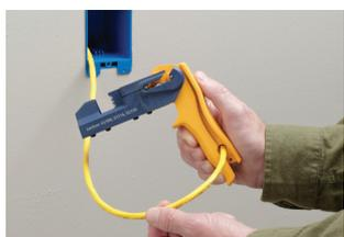
1. Pele el cable del conector con un pela cables estándar o con el pelador de cables integrado.
