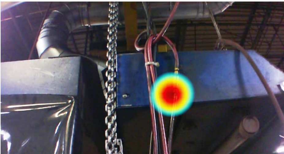
Imagen tomada con la cámara acústica industrial ii900 de una fuga de aire en un entorno industrial.
